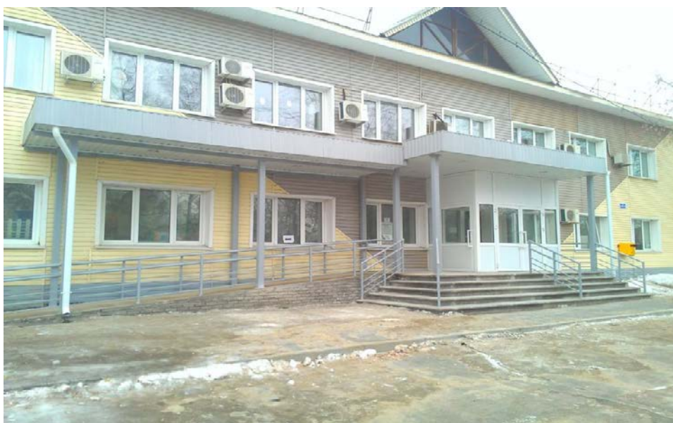
Реконструкция входной группы в Центре обслуживания клиентов в городе Выкса
